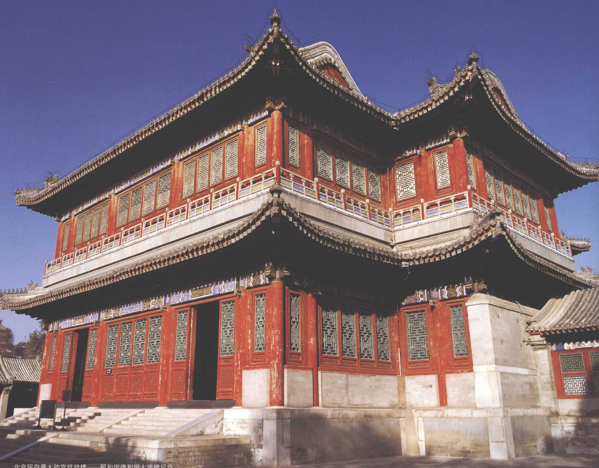
北京现存最大的宫廷戏楼——颐和园德和园大戏楼后台
