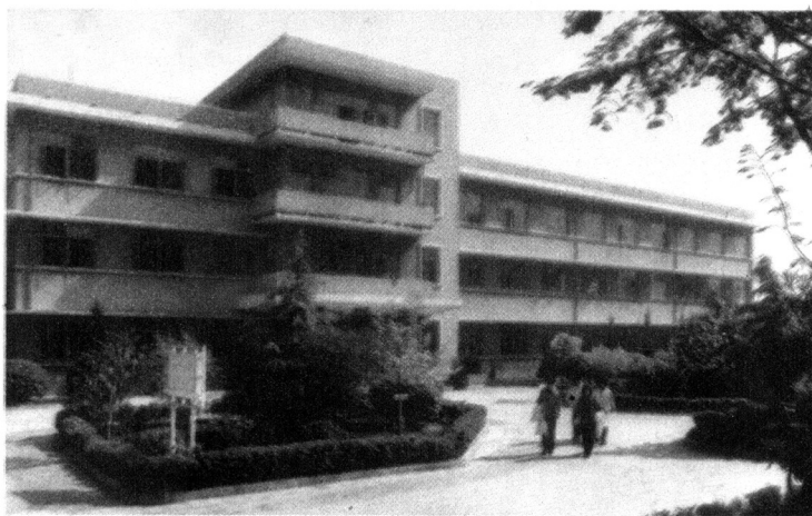
扬州市卫生防疫站业务楼
