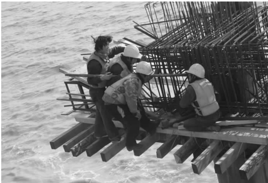
江苏盐城，民工在黄海上修筑大桥。杨金志摄。
