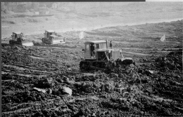
河床土方施土
