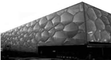
“水立方”的塑料膜材料具有隔热、保温和自洁功能
