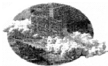
(B) 定向爆破拆除楼房
