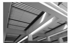
安装在屋顶的太阳能集热管
