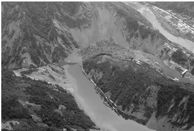
图 源 山体崩滑毁坏公路、铁路交通
