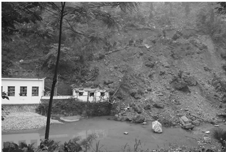
图 圆 山崩和滑坡毁坏了村镇
