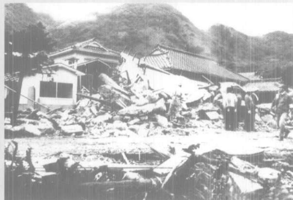
1974 年 5 月 9 日伊豆半岛 6.9 级地震,死 38 人伤 100 余人,石廊崎了望台震坏,人行道有严重裂缝
