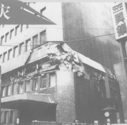
钢筋混凝土式建筑物破坏
