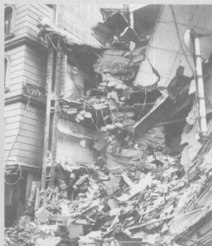
钢架式建筑物破坏
