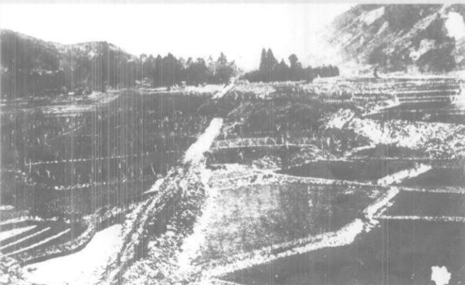
产生世界闻名的巨大地震断层的地震: 1891 年 10 月 28 日 8.4 级浓尾地震,死 7273 人,产生的断层长约 100km,垂直位移 2~6m,水平错动 2~8m
