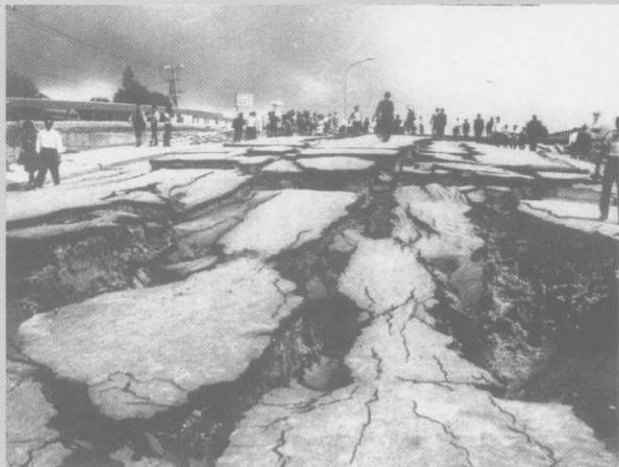
地震液化灾害严重的新潟地震:1964年6月16日 7.5级地震, 粟岛隆起0.9~1.3m
