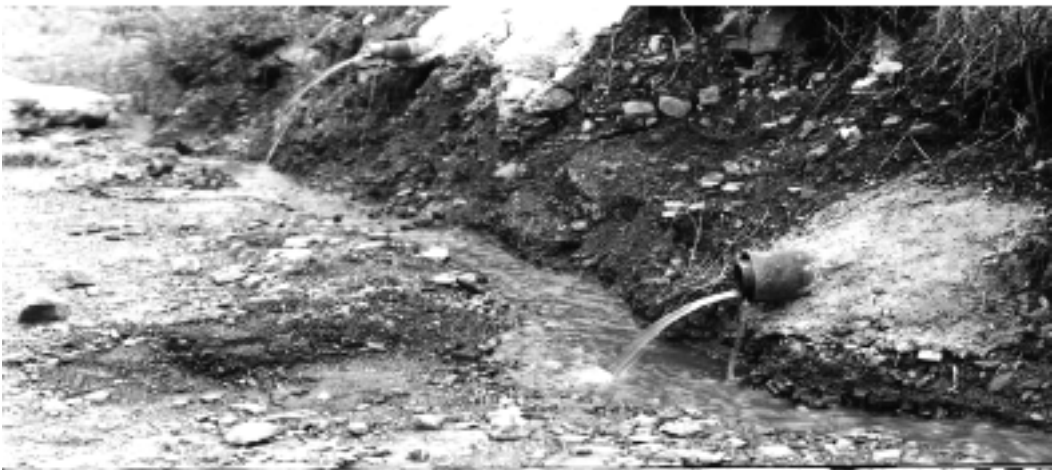
图 9 成昆铁路莫洛滑坡排水孔施工
