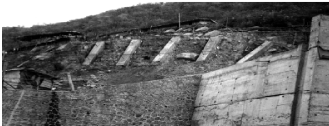
图 10 某隧道西洞口滑坡锚索工程
