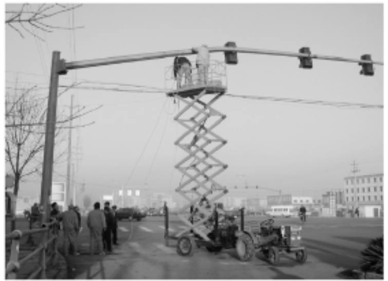
图 2-1-2 架设过路电缆
