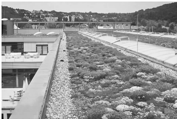
图 1-6 屋顶沙生植物需要充足的阳光
