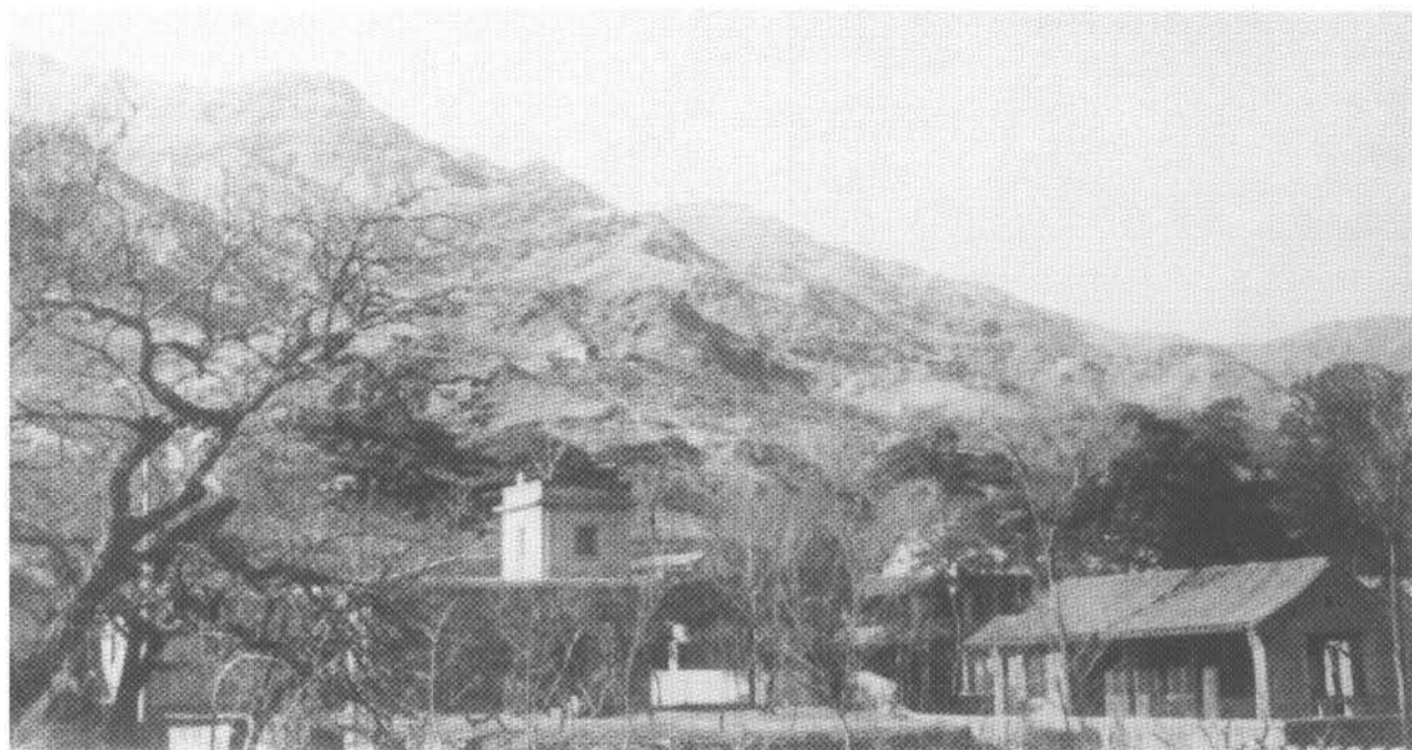
1930年李善邦拍摄的鹫峰地震台全貌
