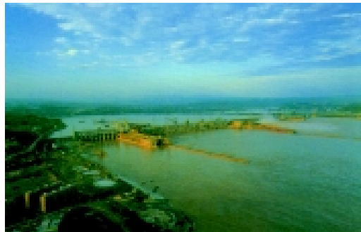
CC 葛洲坝水利枢纽工程位于南津关东的长江上，有“长江第一坝”之称。
