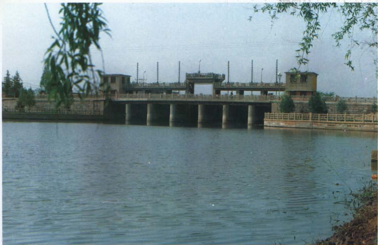
通江运河上的大闸
