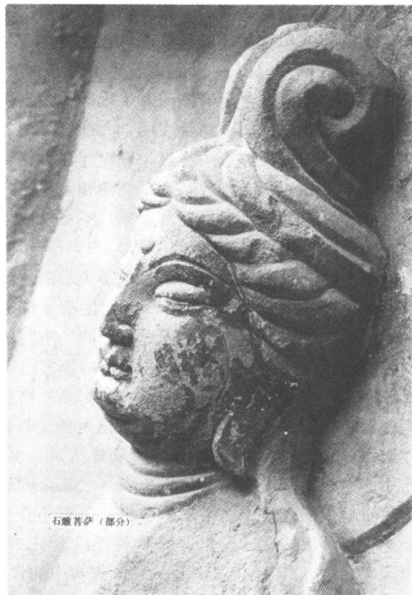
图 1-12 甘肃炳灵寺石雕因小环境改变造成的粉化
