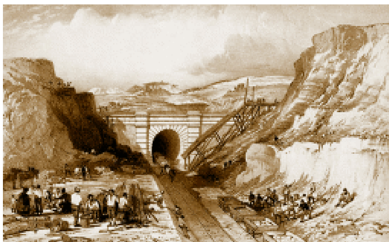
铁路隧道工程
