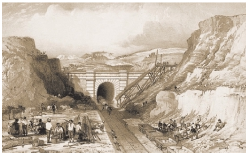
铁路隧道工程
