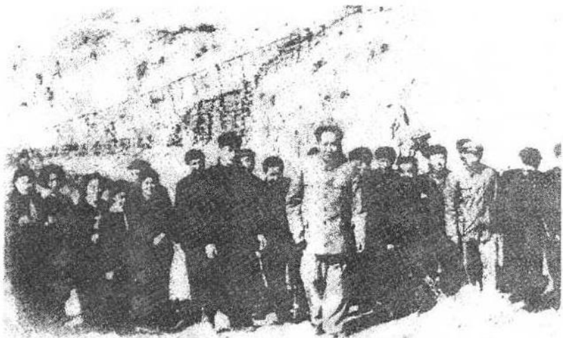
1954年4月12日,毛泽东主席视察官厅水库工程
