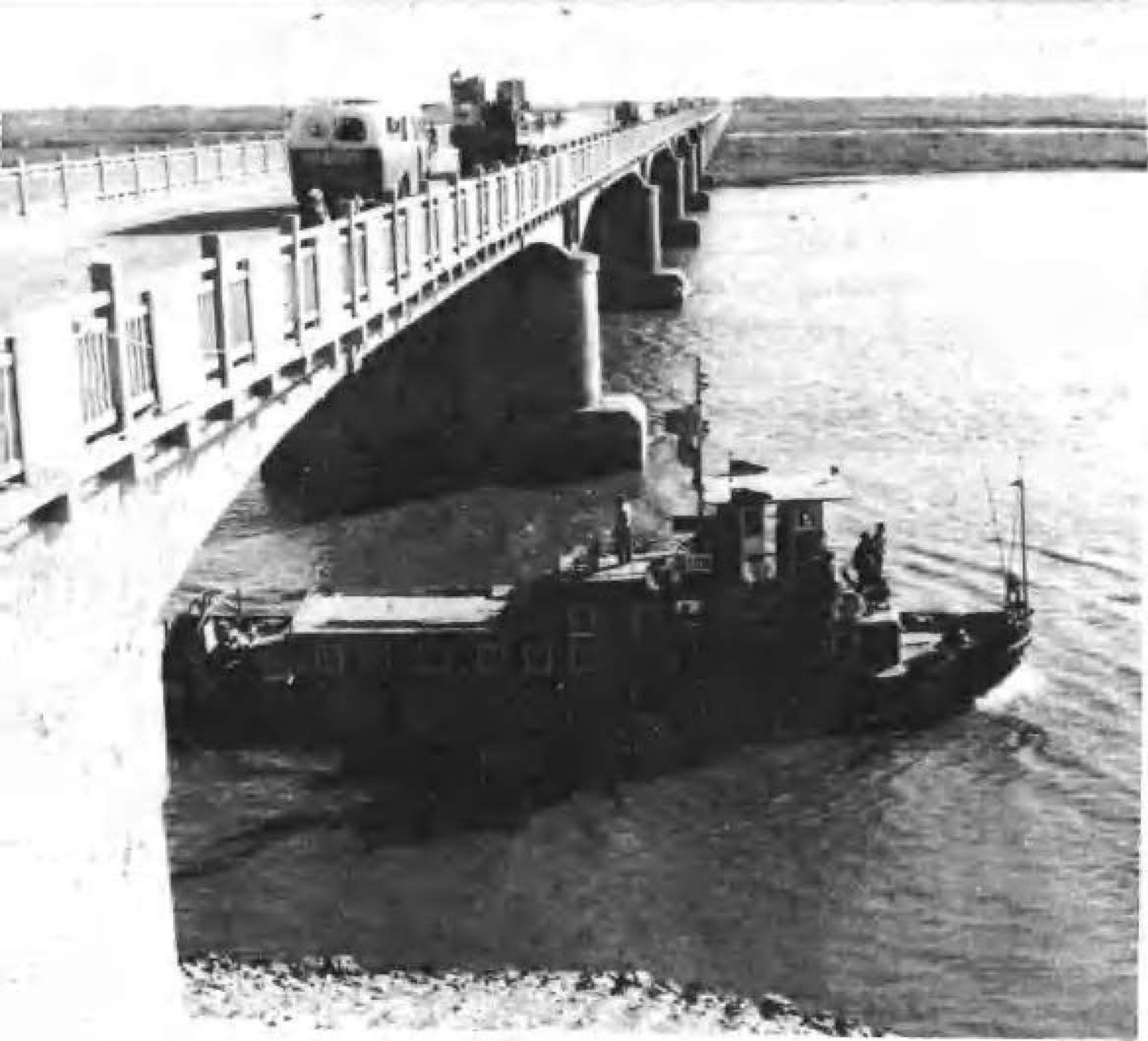
前郭—扶余松花江大桥
