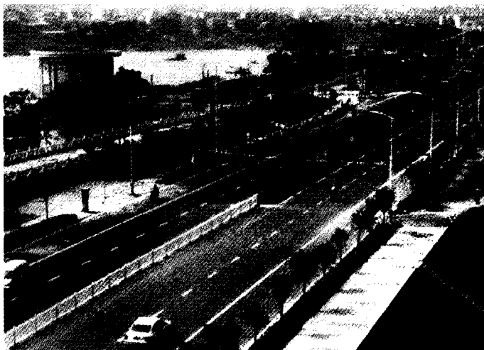
图为堤路园一期工程竣工通车
