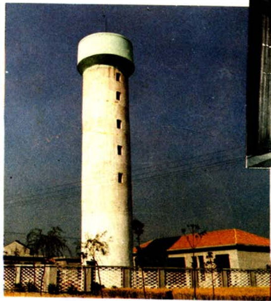
自来水厂水塔
