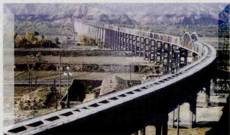
“引大入秦”工程高架渡槽
