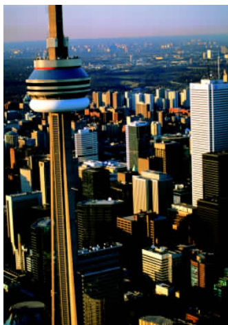
✦ 加拿大国家电视塔是世界最高的建筑之一。
