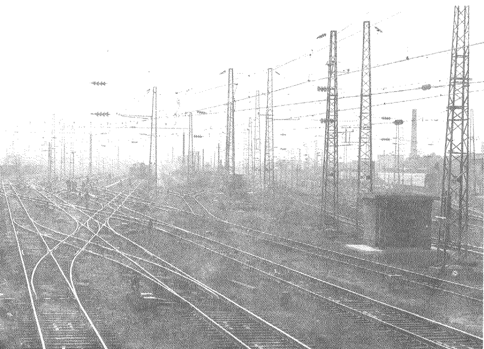
西北最大的电气化车站——兰州西站
