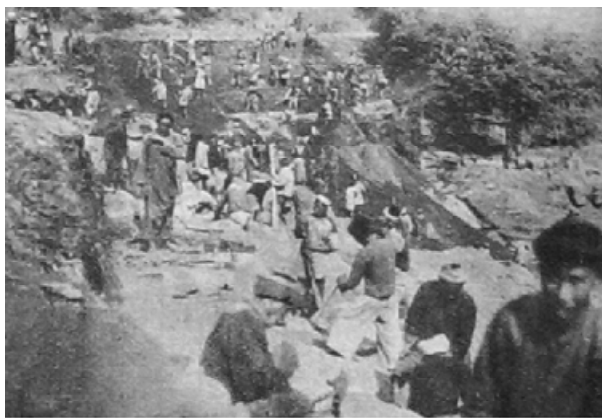
川黔公路筑路时的情形。
