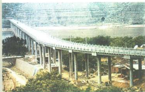
△ 连接晋、陕的佳临大桥
