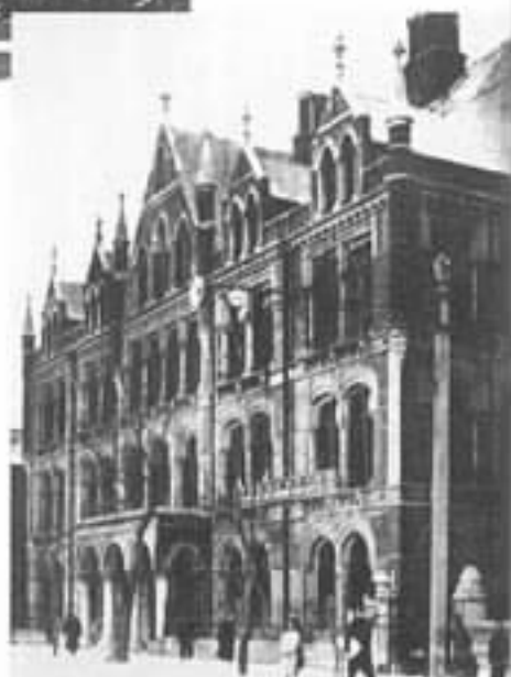
中国通商银行大楼
