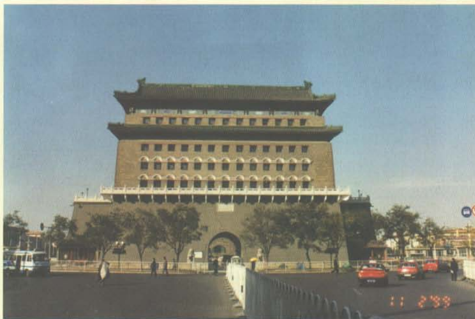
照片 17 北京正阳门箭楼 (曹民希摄)
