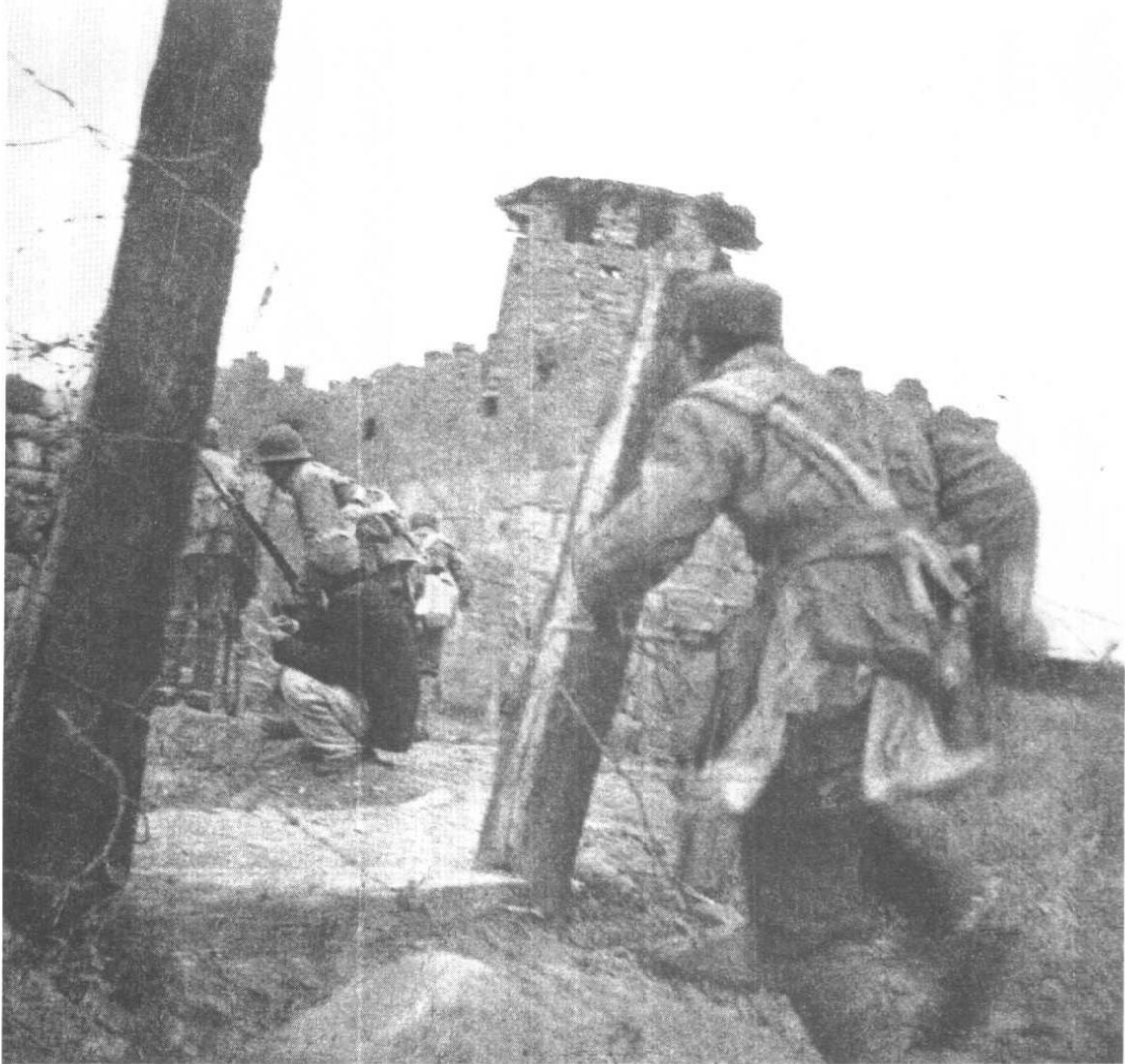
某部在测石冲过铁丝网，围歼自阳泉逃窜之敌。
