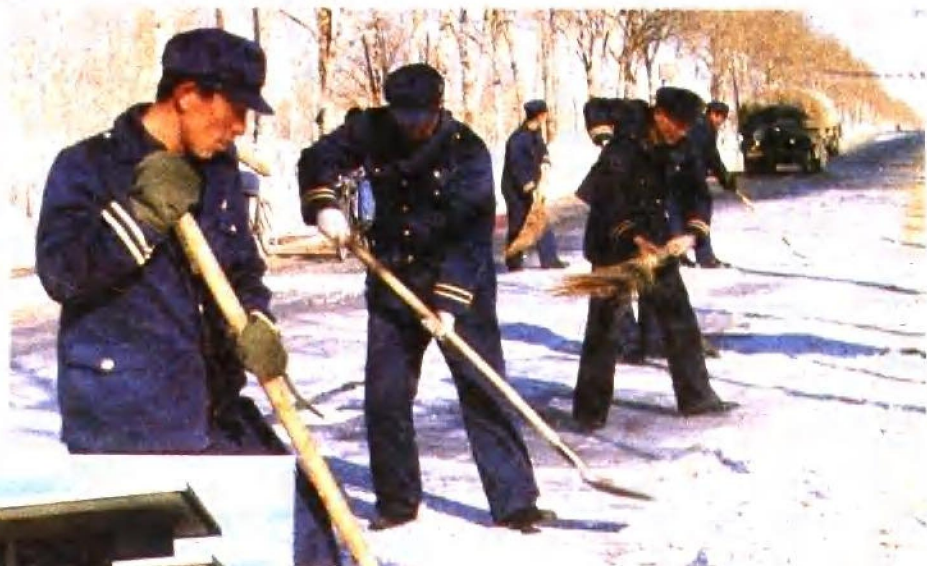
二台子养路工区工人清除路面积雪
