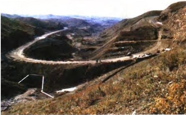
张家口至宝昌公路坝头改线施工
