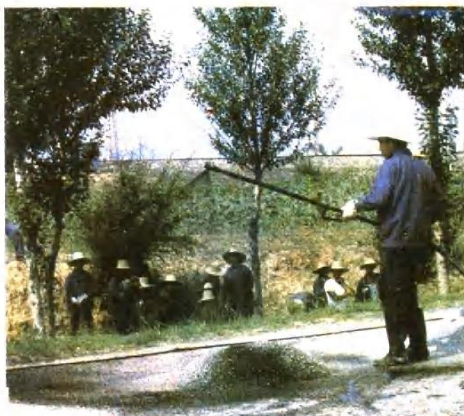
沥青撒布机喷油试验
