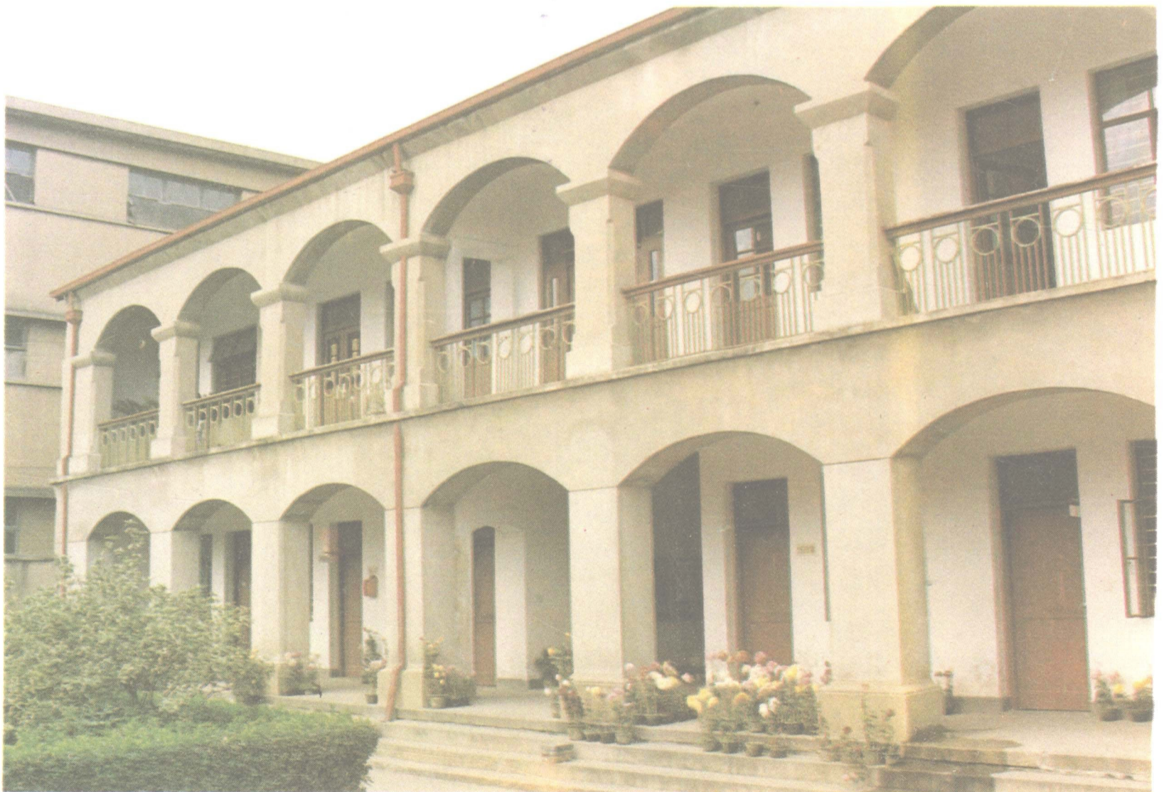
下图为苏州关税务司署（俗称“洋关”）旧址，位于葑门外觅渡桥西堍。
