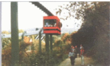
多特蒙德悬吊单轨系统
