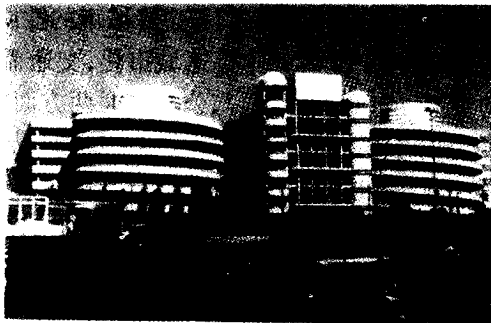
照片 1-2 从侧面看联合航空公司职员专用停车场，可以看到两条螺旋式坡道和中间的几台电梯
