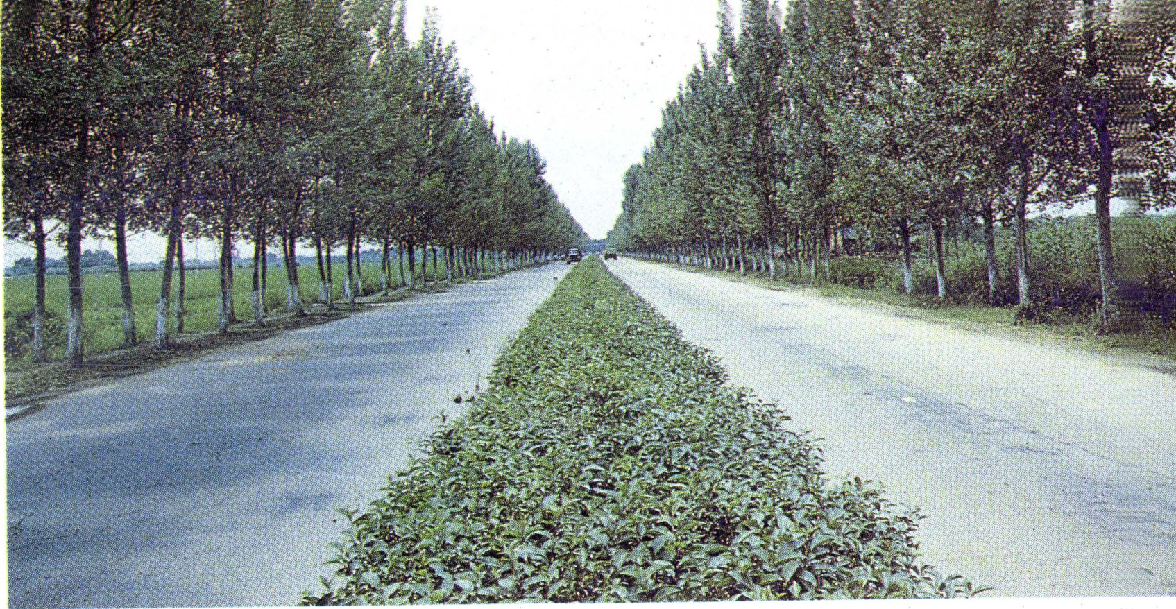
淮阴—沐阳一级公路
