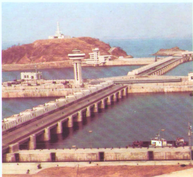
图为大同江下游南浦西海水闸一角。
