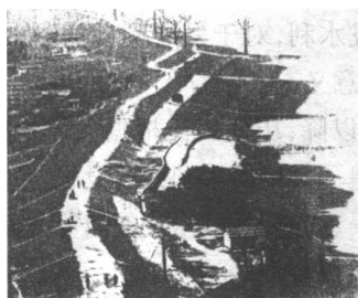
加固后的韩江北堤
