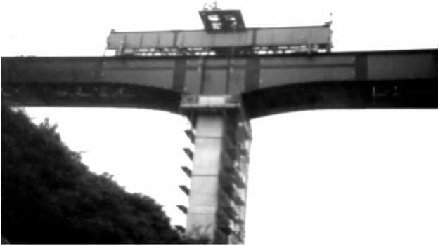
图 1-1-1 摇摇施工中的今别府川大桥
