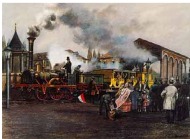
图 1-1-3 德国第一条铁路开通时的情景
