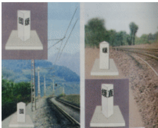
图 1-17 圆曲线与缓和曲线始终点标
