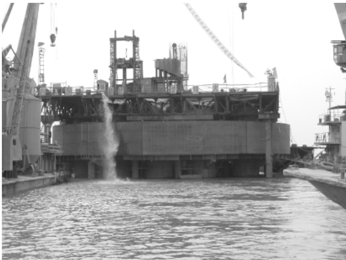
图 17 主 6 # 墩钻孔施工与有底钢套箱下沉同时作业
