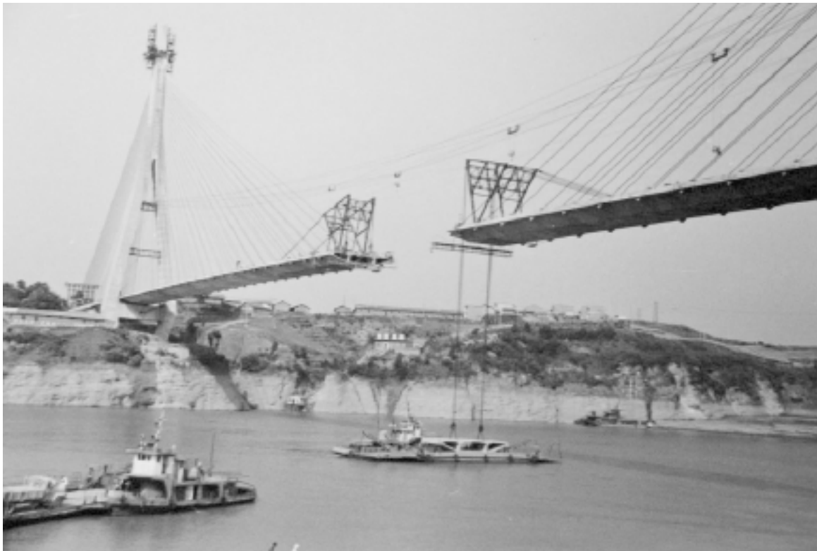
图9 三角吊机悬拼主梁
