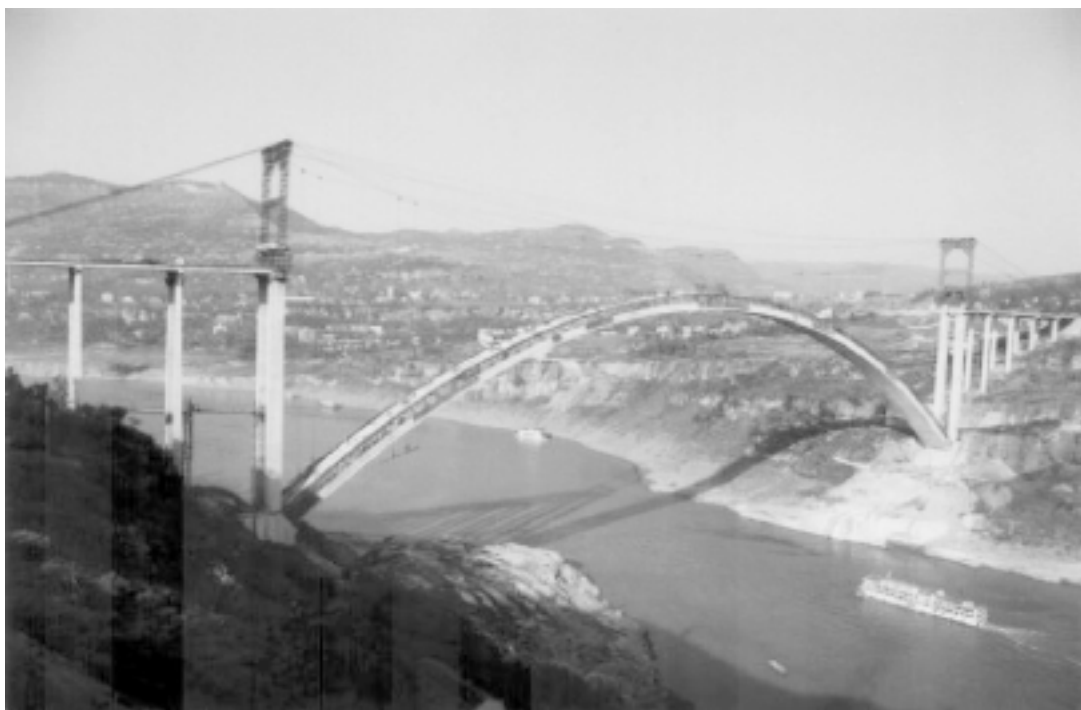
图 13 六工作面施工
