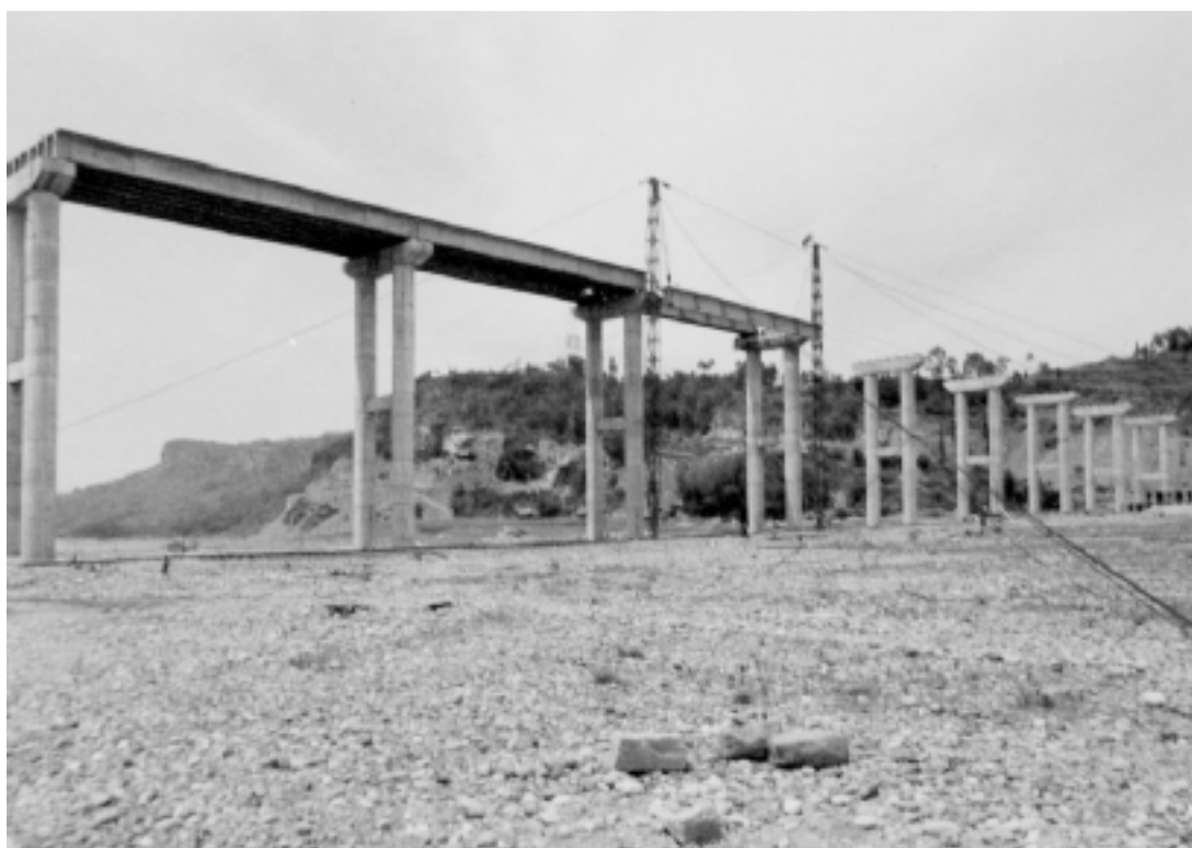
图7 格构扒杆吊装30mT梁
