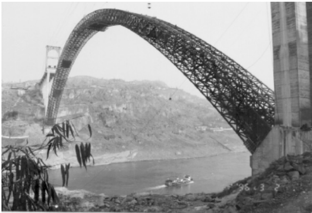
图 12 缆索吊机悬拼 36 段劲性
