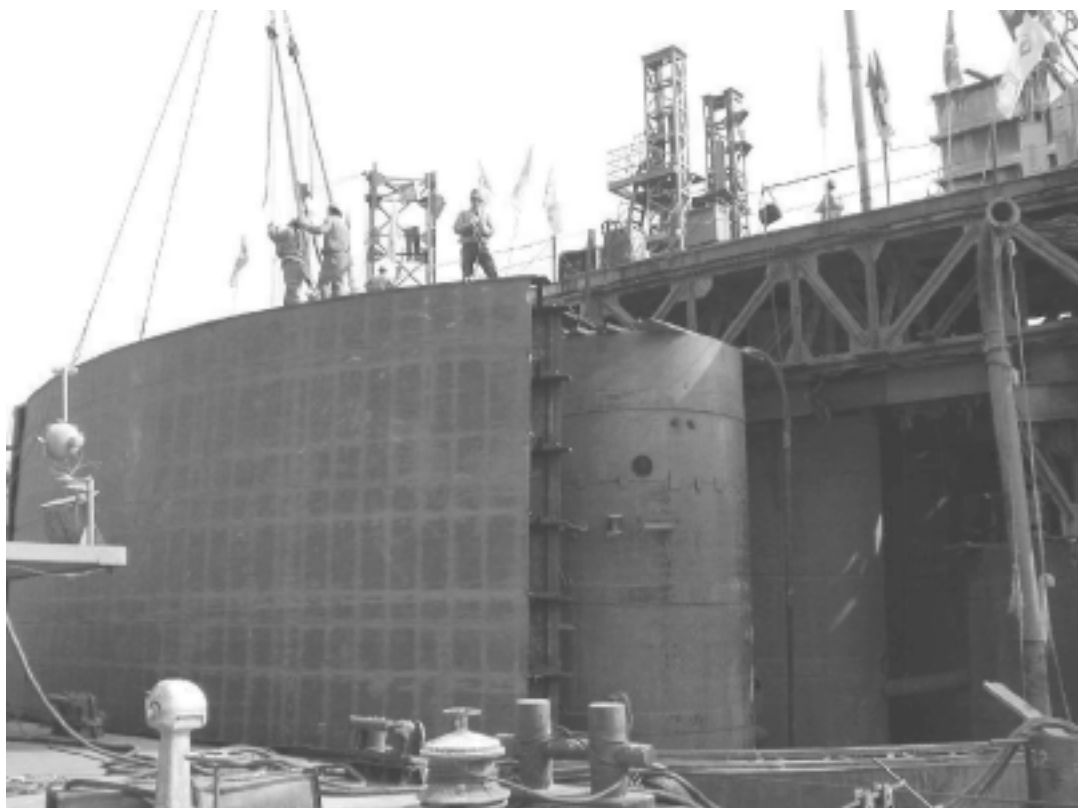
图 18 主 5 # 墩钻孔施工和无底钢套箱下沉平行施工
