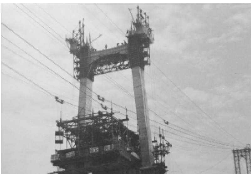
图6 滑升翻模施工索塔
