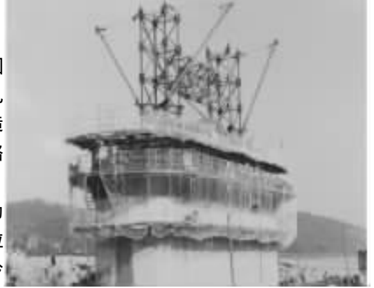
图5 墩身滑模施工
