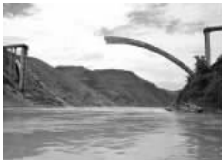
图2 无平衡重转体施工
