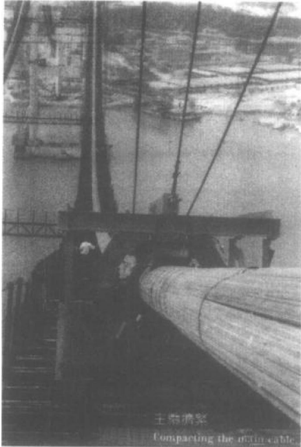
图 1—12 作业中的主缆挤紧机
