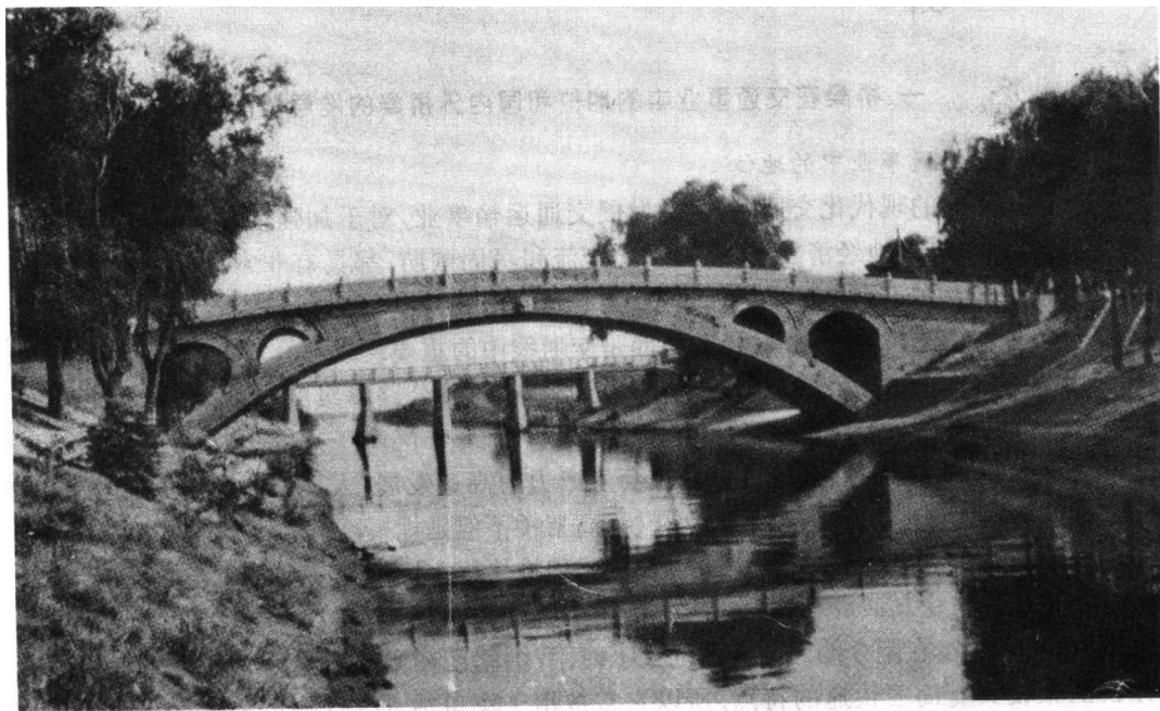
图 1-1-1 河北赵县赵州桥（公元 605 年）
