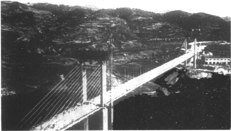
图 1.7 贵州乌江大桥
