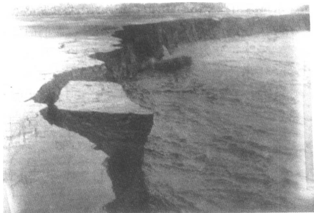
图 1-5 沙岸崩塌
