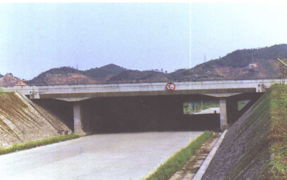
南沙互通立交桥，主跨 21\text{m} ，无桥台的双悬臂刚构加搭板。位于主收费广场前 R=2700\text{m} 平曲线上，宽 118.6-133.8\text{m}
