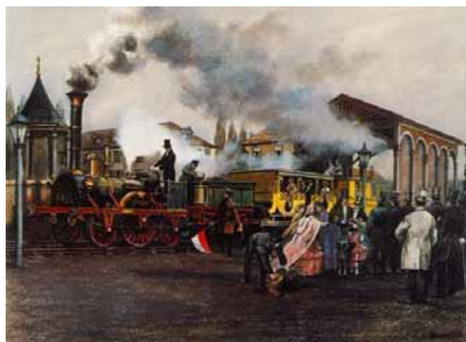
图 1-1-3 德国第一条铁路开通时的情景
