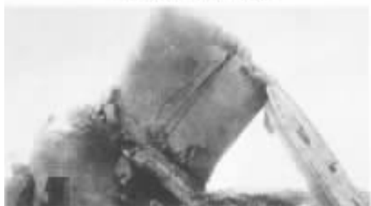
汉沽祖日化工厂水塔倒塌
