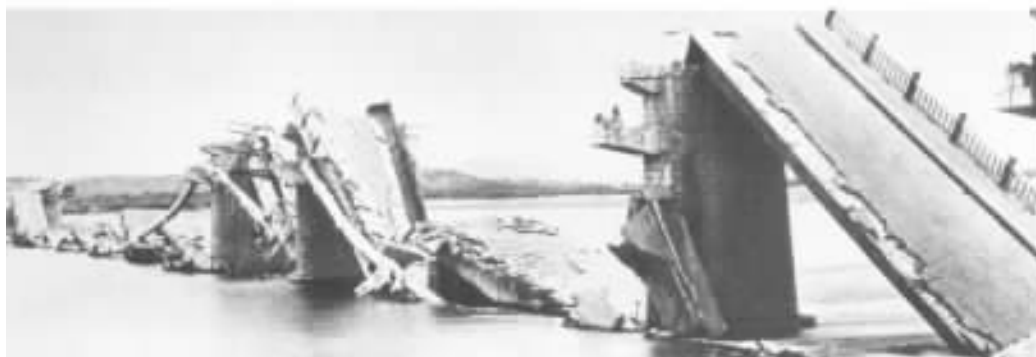
滦河大桥桥面塌落
