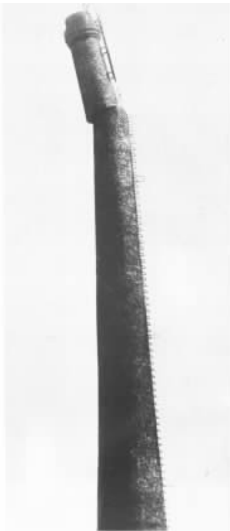
三河县化肥厂烟筒折断
