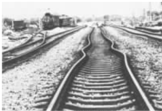
丰南火车站铁轨弯曲变形
