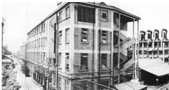
图2-1 上海英美烟草公司，钢筋混凝土厂房；引自陈从周、章明主编的《上海近代建筑史稿》
