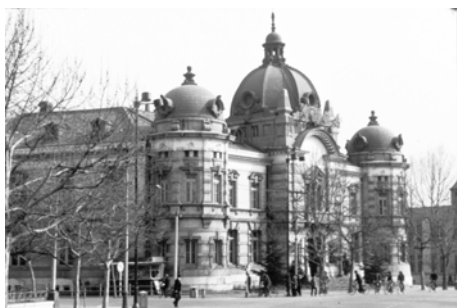
图2-10 大连，横滨正金银行大连支行，1910 年，建筑师：（日）“满铁”建筑课大田毅
