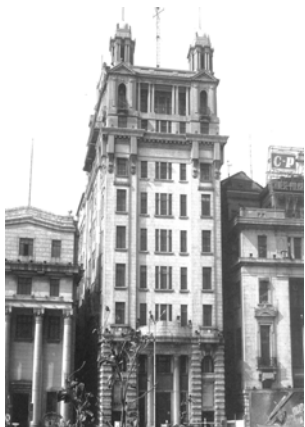
图2-2 上海，字林西报社，1924年，（英）德和洋行；钢筋混凝土结构，上海最早的十层以上的建筑物。引自吴光祖主编《中国现代美术全集·建筑艺术·第一卷》
